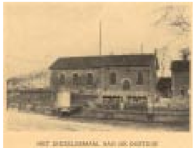
Het diezelgemaal aan de Oostdijk, 1939
